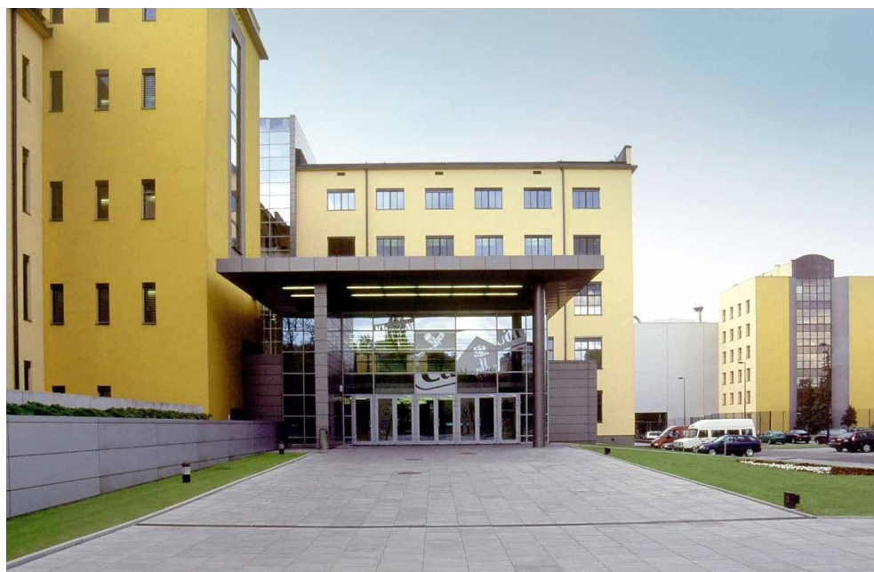
Ryc. 20. Wejście pracownicze do części produkcyjnej w zakładzie Philip Morris Polska SA na Czyżynach w Krakowie.
