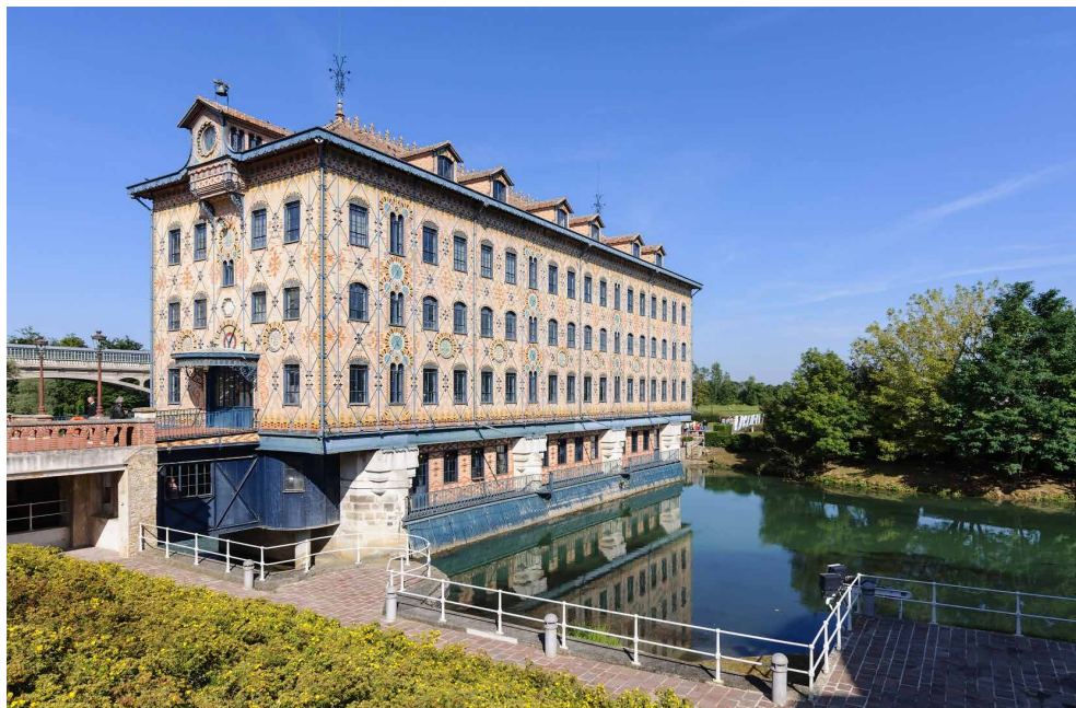
Ryc. 82. Jeden z pierwszych obiektów przemysłowych o metalowej konstrukcji nośnej i o metalowej konstrukcji fasad z wypełnieniem ceramicznym – fabryka czekolady Meniera w Noisiel-sur-Marne pod Paryżem, zrealizowana w 1872 roku według projektu Jules’a Saulnier’a – stan z roku 2012.
