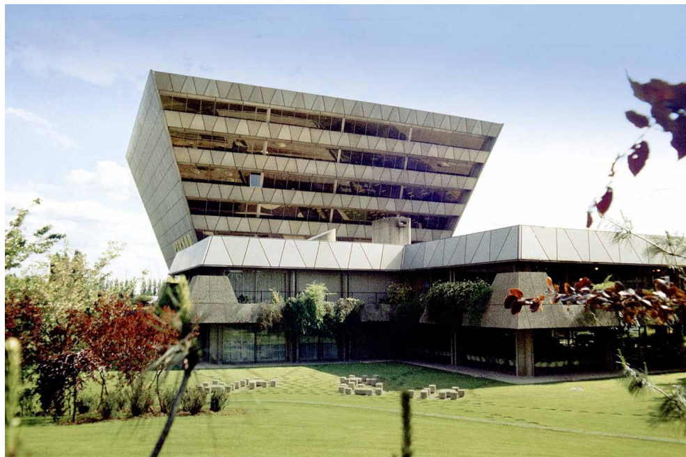
Ryc. 18. Budynek biurowy (forma odwróconej piramidy) oraz część badawczo-laboratoryjna (horyzontalna) zakładu produkcji niealkoholowych napojów Pernod-Ricard w Créteil pod Paryżem.
