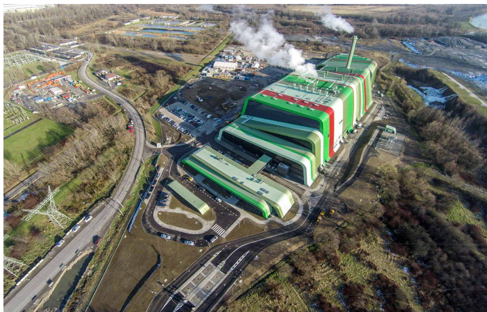
Ryc. 95. Zakład Termicznego Przekształcania Odpadów Krakowskiego Holdingu Komunalnego SA zrealizowany w roku 2016 według projektu zespołu: Bogusław Wórczewski, Michał Taller, Filip Łapiński i Jakub Baczyński w widoku z lotu ptaka.
