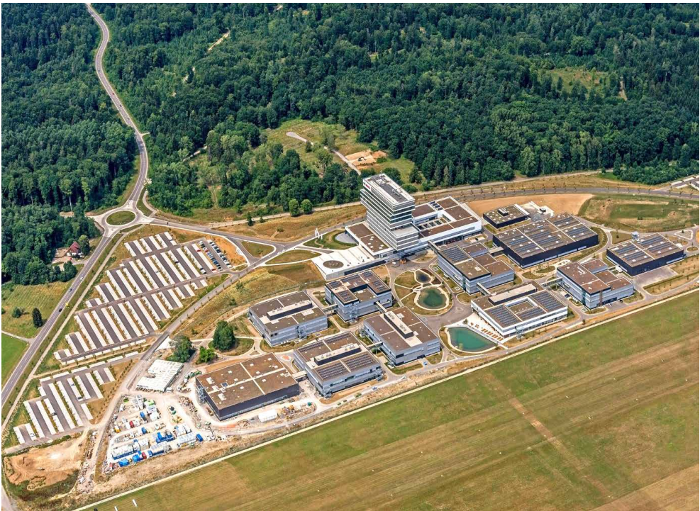
Ryc. 15. Centrum badawczo-rozwojowe koncernu Bosch (Robert Bosch GmbH Zentrum für Forschung und Voraentwicklung) w kampusie Renningen pod Stuttgartem, zrealizowane w roku 2015 dla 1770 pracowników, głównie inżynierów, techników i informatyków.
