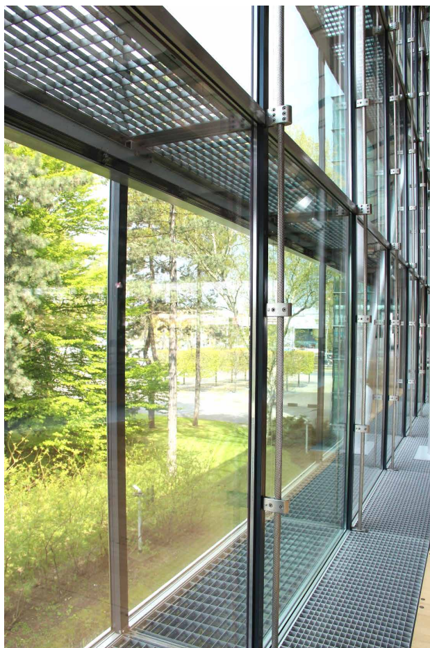
Ryc. 90. Detal podwójnej, przeszklonej elewacji w Szklanej Manufakturze koncernu Volkswagen AG w Dreźnie.
