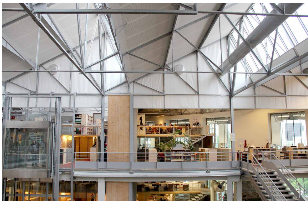
Ryc. 40. Szedy doświetlające wielkoprzestrzenne wnętrza biur projektów kolei francuskich, zrealizowanych w zrewitalizowanym budynku dawnych zakładów przemysłu samochodowego (Renault), wzniesionego w Paryżu roku 1891.
