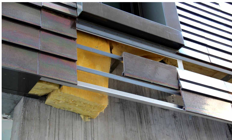
Ryc. 67. Detal elewacji realizowanej metodą lekka sucha, z osłonowymi elementami ze szkliwionej ceramiki, Paryż, rue Claude Bernard 21 bis.
