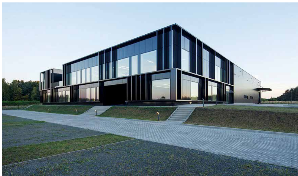
Ryc. 100. Widok zakładu firmy Pivexin Technology w miejscowości Nędza na Górnym Śląsku (powiat raciborski), zrealizowanego w roku 2018 według projektu pracowni MUS Architects – Adam Zwierzyński i Anna Porębska.
