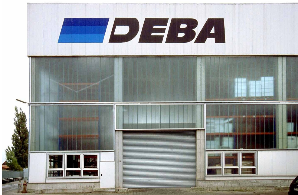
Ryc. 86. Typowy przykład realizacji przemysłowej z końca XX wieku w duchu technicznego racjonalizmu. Fragment elewacji hali produkcyjnej zakładu prefabrykacji łaźienek Deba w Salzwedel w Saksonii-Anhalt.
