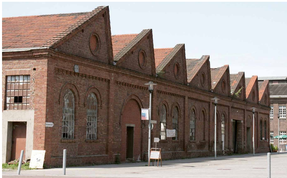
Ryc. 39. Dach szedowy (pilasty) nad wzniesioną pod koniec XIX stulecia halą zakładów metalowych, nieczynnej już kopalni Zeche Ewald w Herten (Nadrenia Północna- Westfalia, Niemcy), stan z roku 2010.
