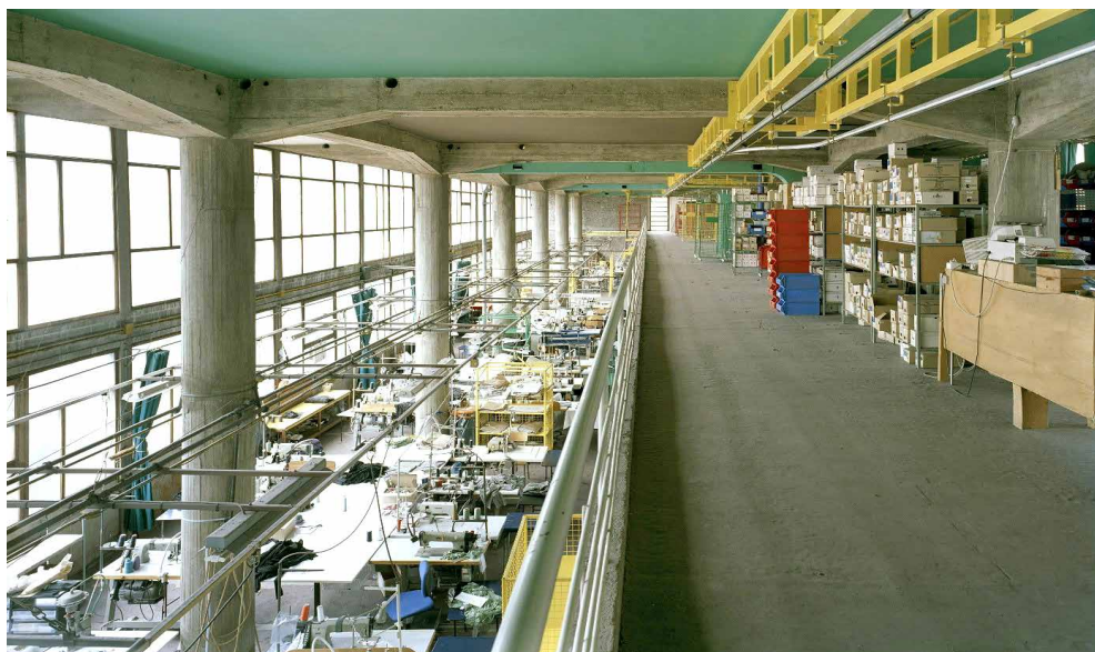
Ryc. 85. Hala produkcyjna fabryki Claude-et-Duval w Saint-Dié-des-Vosges (region Wogezów we Francji), wytwarzającej dzianiny (skarpetki, pończochy, bielizna), ukończonej w roku 1951 według projektu Le Corbusiera.
