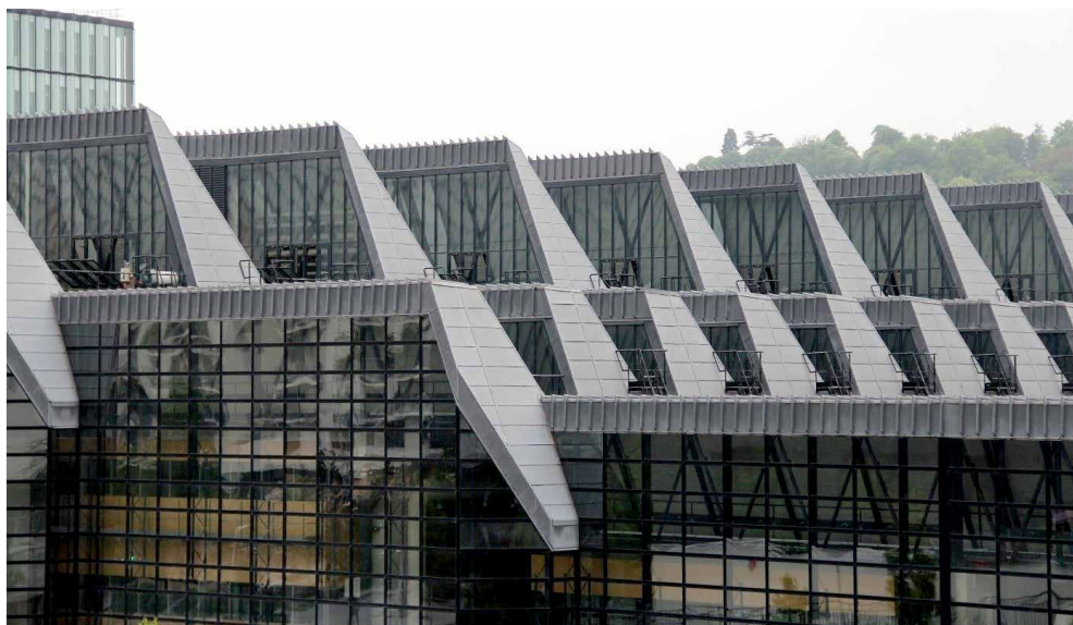
Ryc. 42. Wysokie szedy stanowiące zarazem elementy nośne dachu o dużej rozpiętości w zakładzie montowni Renault (pawilon 57 Métal) w Boulogne-Billancourt pod Paryżem, stanowią atrakcyjną, rzeźbiarską, pełną ekspresji formę. Obiekt zrealizowano w roku 1984, według projektu Claude'a Vasconiego.
