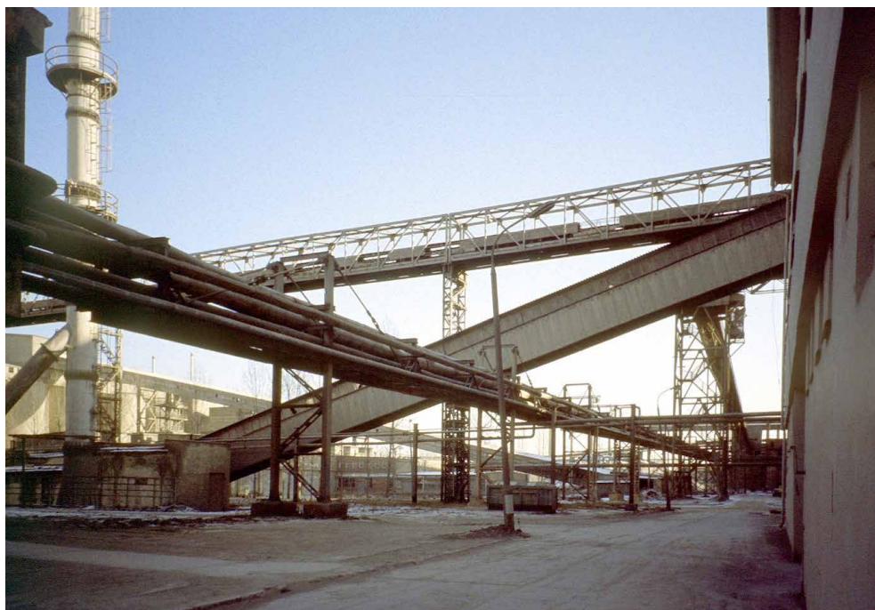
Ryc. 62. Transport pomiędzy wydziałami za pomocą taśmociągów i rurociągów w cementowni w Strzelcach Opolskich
