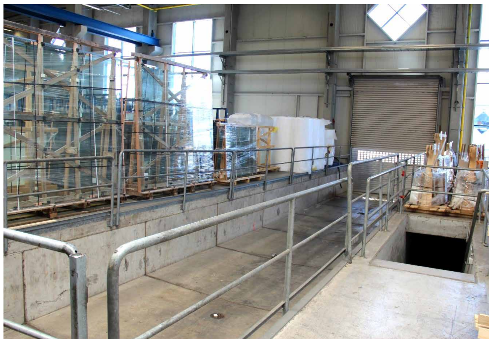
Ryc. 60. Przykład rozwiązania umożliwiającego wjazd samochodu ciężarowego do wnętrza strefy magazynowej w zakładzie produkcji szkła budowlanego Scholl Glas w Nossen w Saksonii, w Niemczech.
