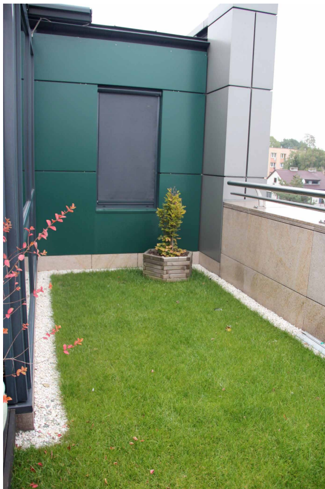
Ryc. 71. Naturalny trawnik na zadaszeniu fragmentu drugiej kondygnacji w drukarni Skleniarz w Krakowie na Azorach.
